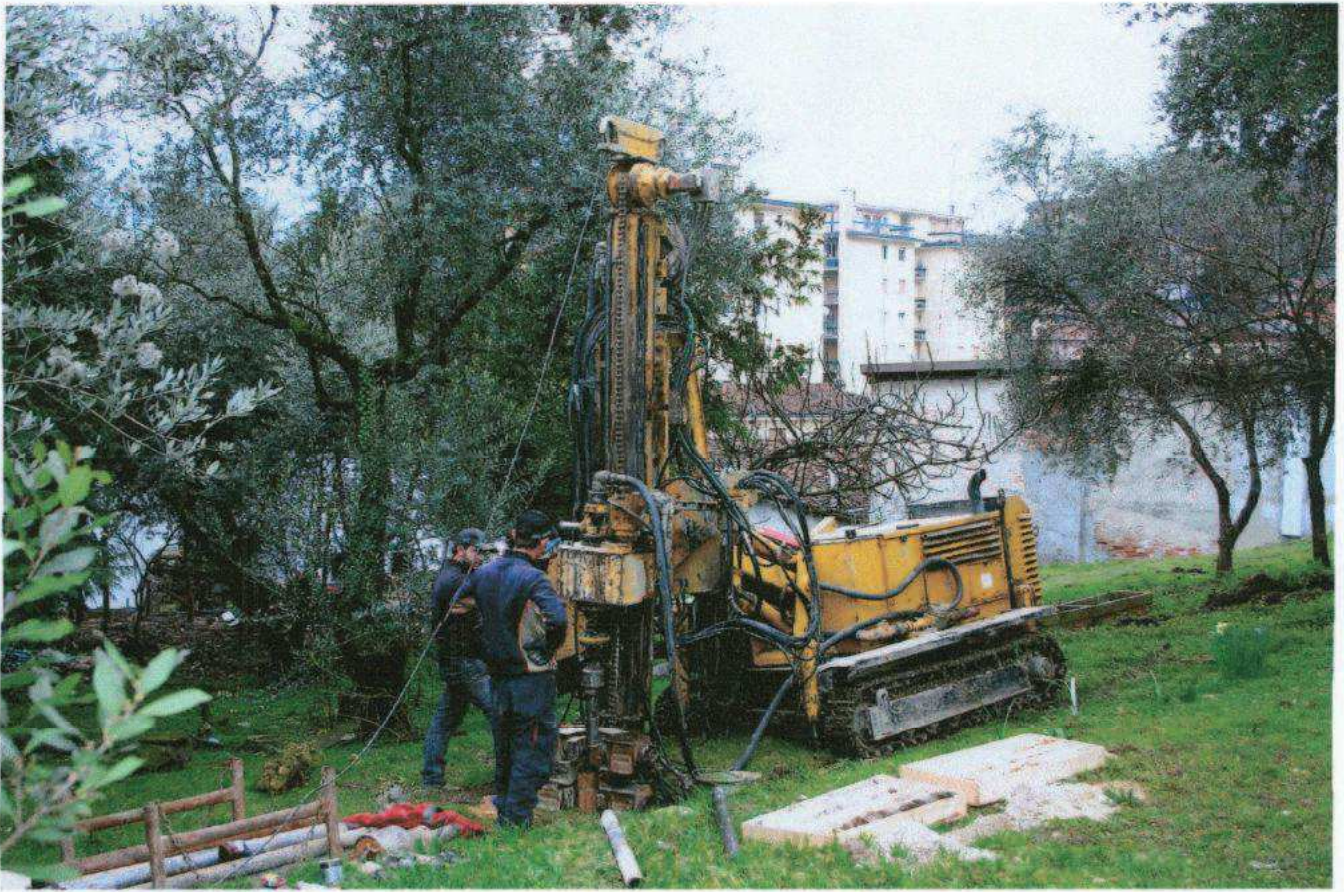
Foto 1- Attrezzatura utilizzata per esecuzione dei sondaggi geognostici
