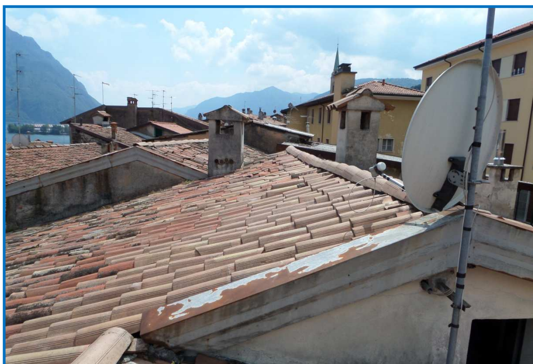
Figura 4: Manto di copertura Blocco "A"
