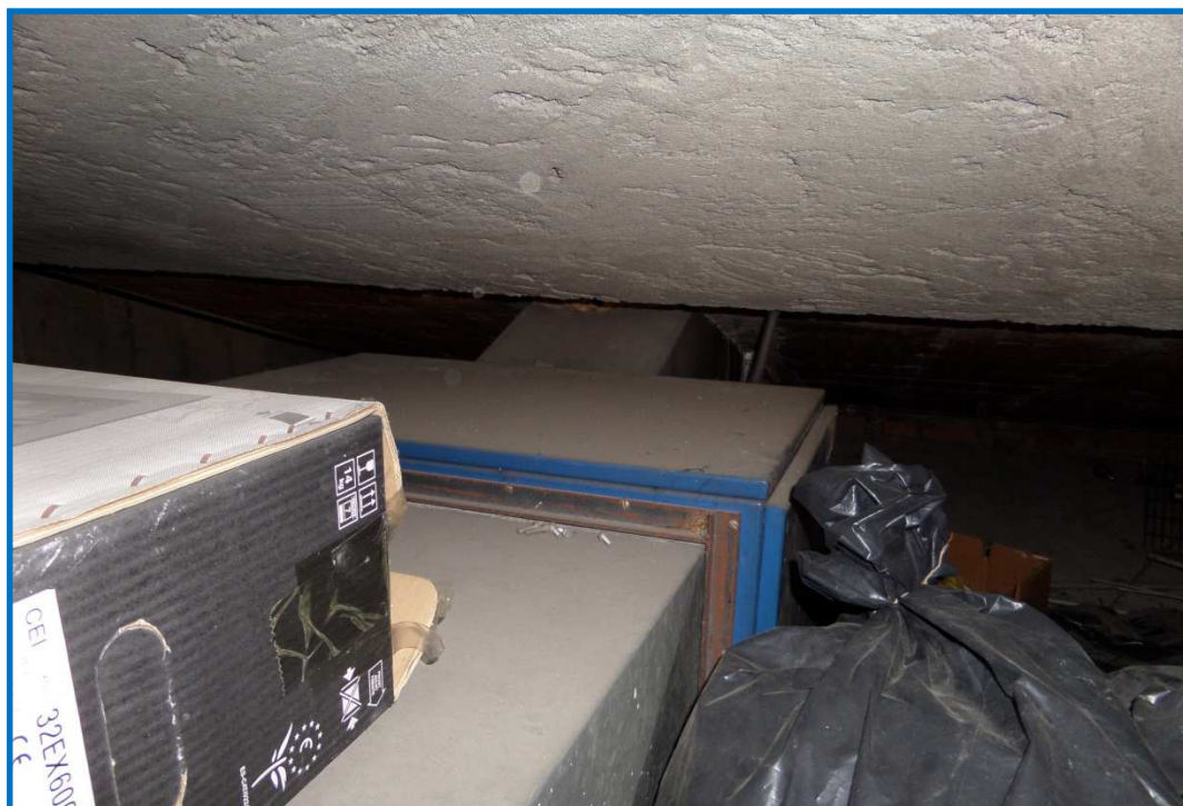
Figura 8: Foto Interna Sottotetto
