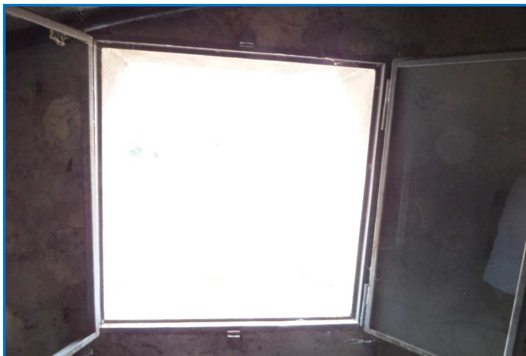
Figura 9: Finestra accesso copertura Blocco "A"
