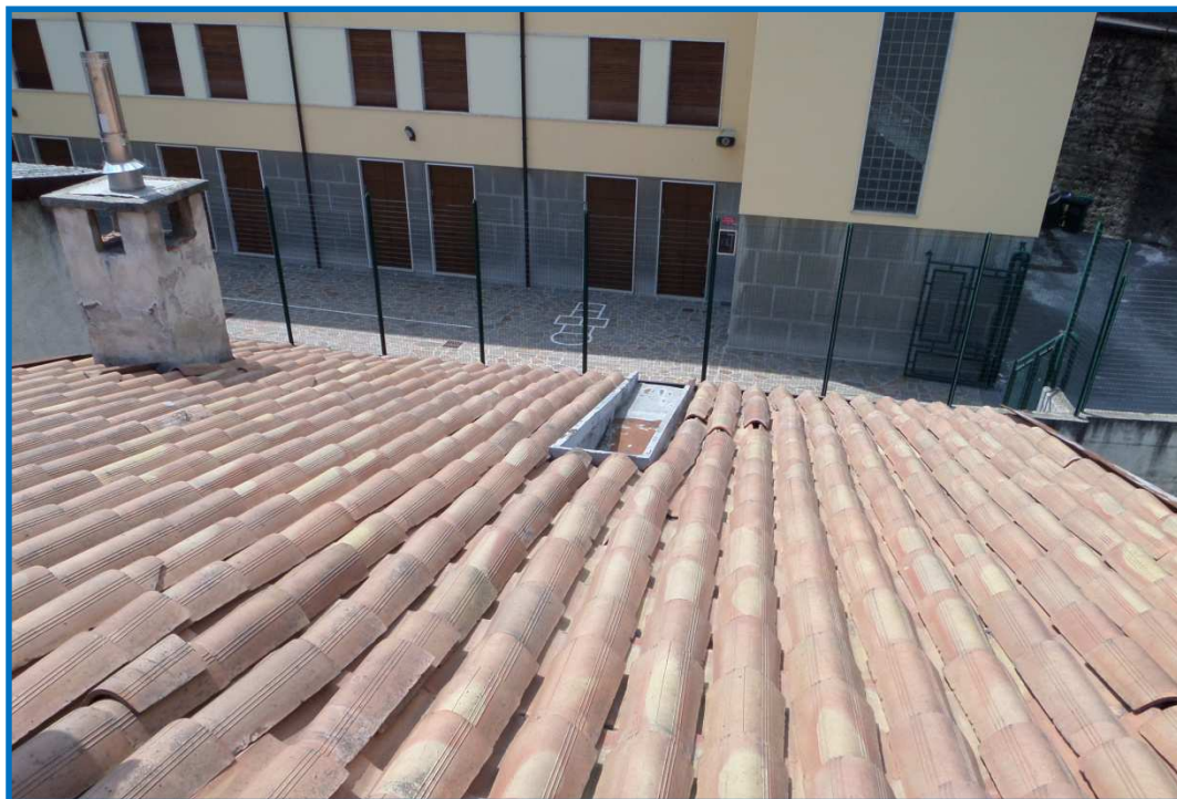
Figura 5: Manto di copertura Blocco "A"
