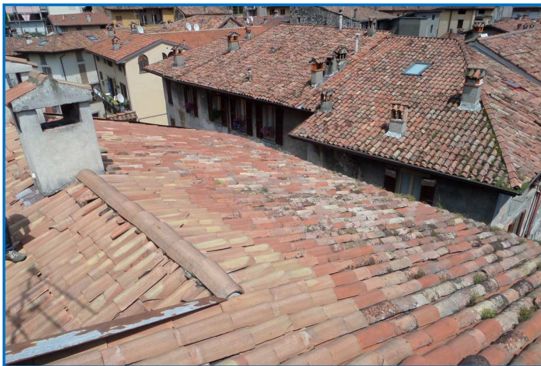
Figura 6: Manto di copertura Blocco "A"
