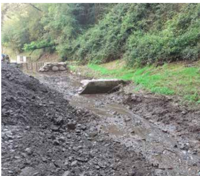
Alveo del Rescudio dopo interventi di pulizia
