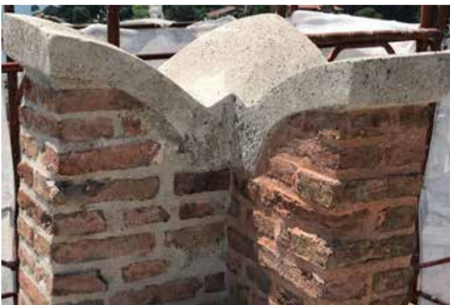
... dopo il restauro
