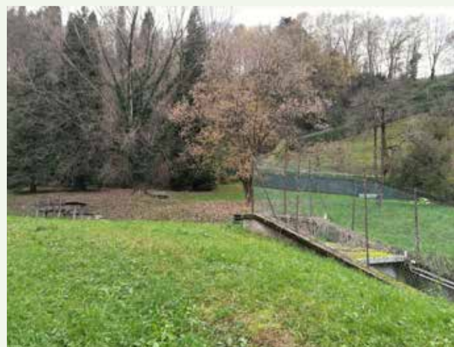
Imbocco della sorgente Biff
