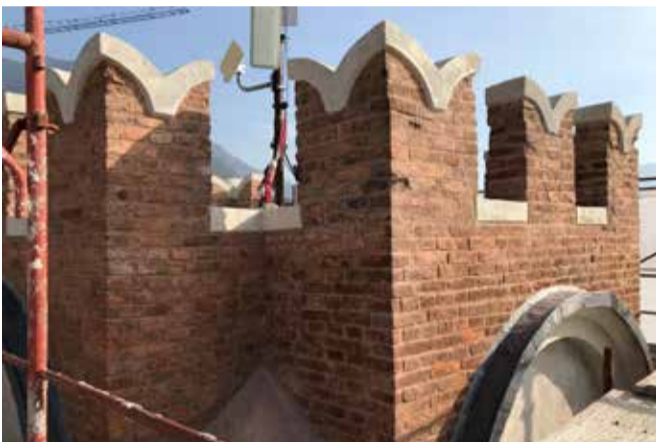
... dopo il restauro
