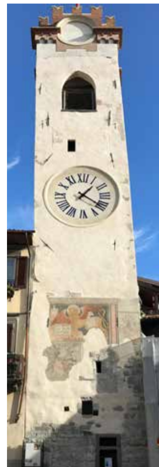
... dopo il restauro
