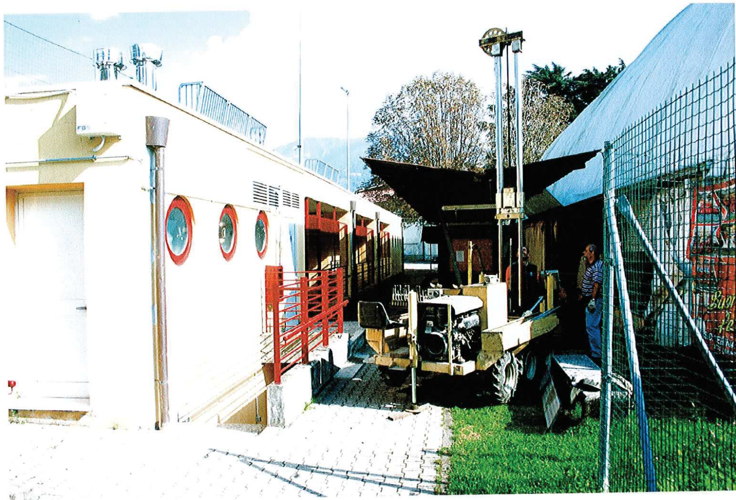
ATTREZZATURA UTILIZZATA PER L'ESECUZIONE DELL'INDAGINE GEOGNOSTICA
