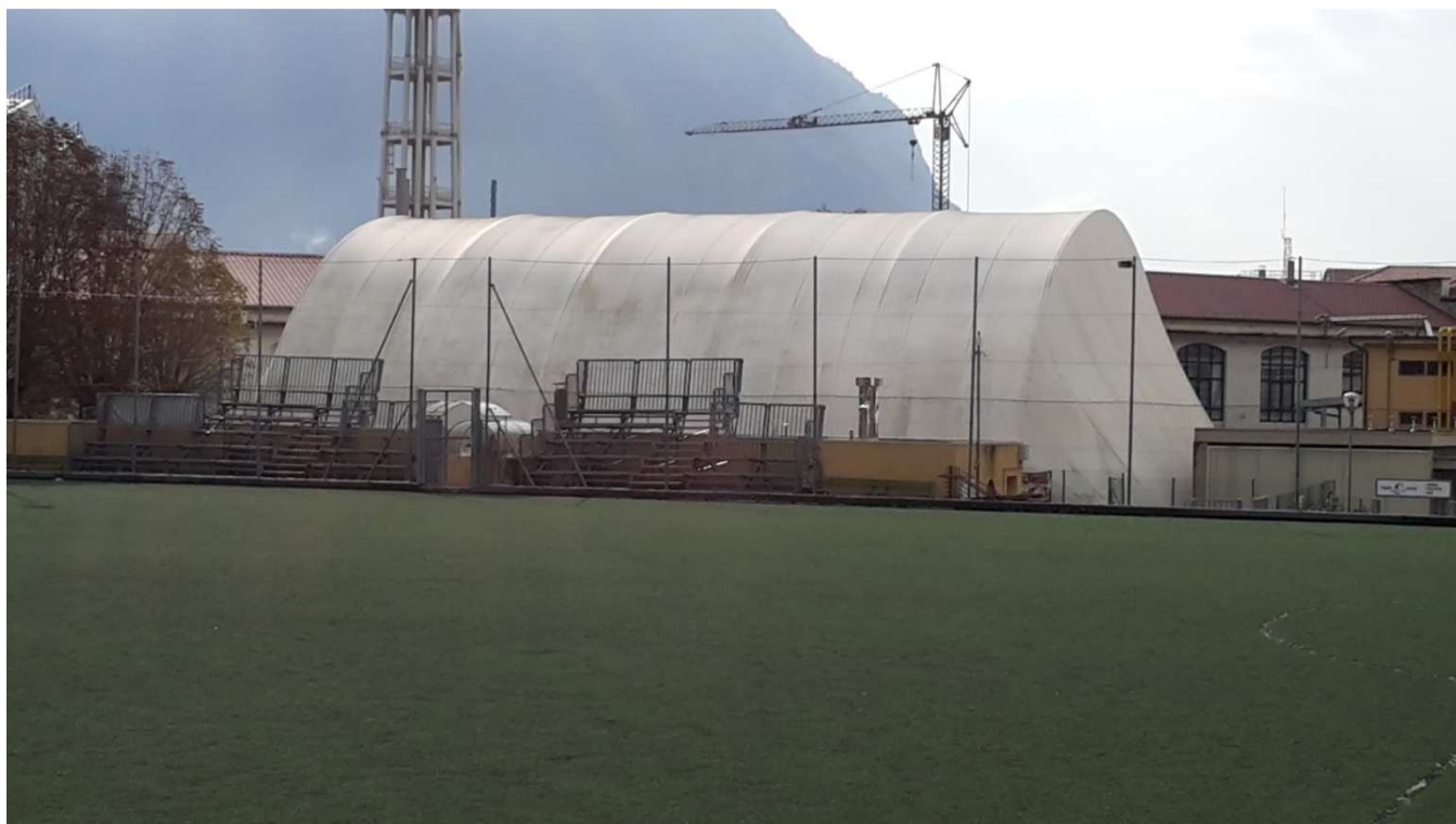
Foto N° 2: Vista frontale dal campo di calcio
