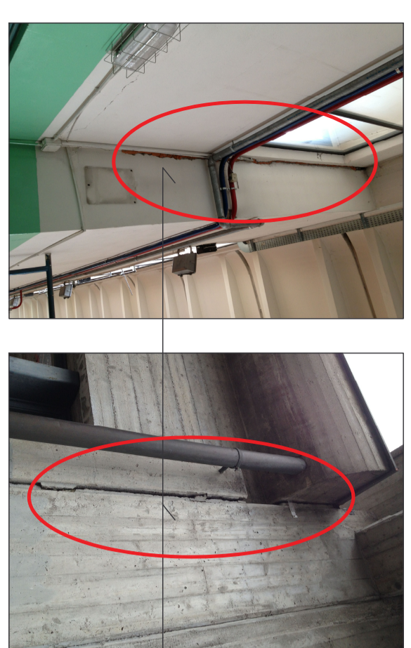
INTERVENTO DI RIPRISTINO GIUNTI STRUTTURALI (VEDI VOCE EP Z10)
